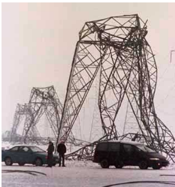
Bild 2. Kraftledningsstolparna bröts successivt sönder av den ökande islasten.
