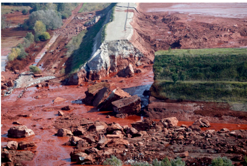
Bild 3: Närbild på dammbrottet i damm nr 10 tillhörande aluminiumfabriken Magyar Aluminium Zrt i Ajka. Foto: Ministry of Public Administration and Justice, Ministry for Government Communication [Public domain], via Wikimedia Commons.
