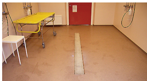
Figur 9. Dränering av golvet i Norrköping
