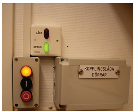
Figur 7. Dörrindikering, när grön lampa lyser får dörren öppnas
