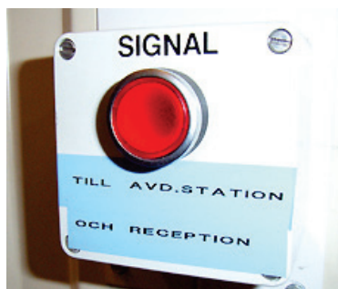
Figur 10. Exempel på enkel signalknapp för kommunikation, saneringsenheten i Karlskrona
