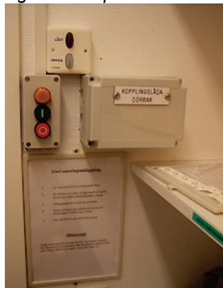
Figur 5. Driftpanel i saneringsenheten, Vrinnevisjukhuset, Norrköping
