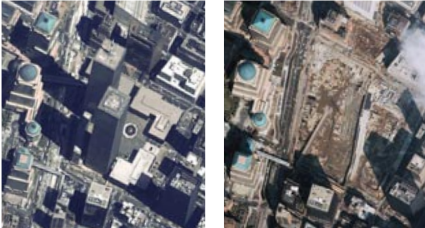
Bild 7. Före och efter attacken. Den vänstra flygbilden över World Trade Center är tagen i juni 2000, den högra i september 2002.
